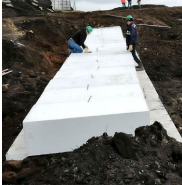
Ilustración 7: Utilización de EPS como elemento de relleno y nivelación en construcciones.
