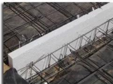
Ilustración 4: Utilización de EPS como Junta de dilatación.
