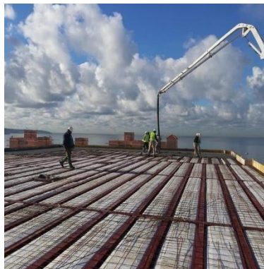
Ilustración 8: Utilización de EPS en vigas y losas en construcciones civiles.
