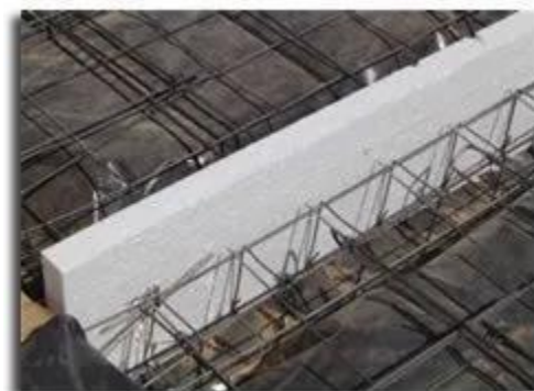
Ilustración 4: Utilización de EPS como Junta de dilatación.
